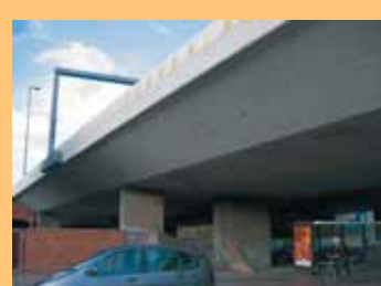
Parallel zur S-Bahntrasse wird zusätzlich eine Autobahnbrücke die Gürtelstraße überspannen, so dass eine Tunnelsituation entsteht wie hier am Heidelberger Platz. Auch der kleine Park wird überbaut.
