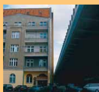
Die Wohnhäuser der Beermannstr. müssen der Autobahn weichen. Die Trasse führt dann direkt an den verbliebenen Häusern entlang, wie hier am Bundesplatz.
