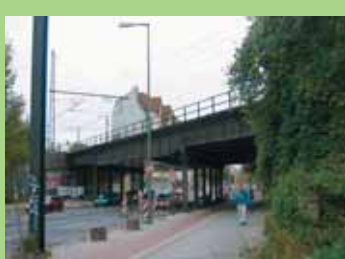
In Friedrichshain überspannt eine alte Eisenbrücke des S-Bahnringes die Gürtelstraße. Entlang der S-Bahntrasse befindet sich ein kleiner Park
